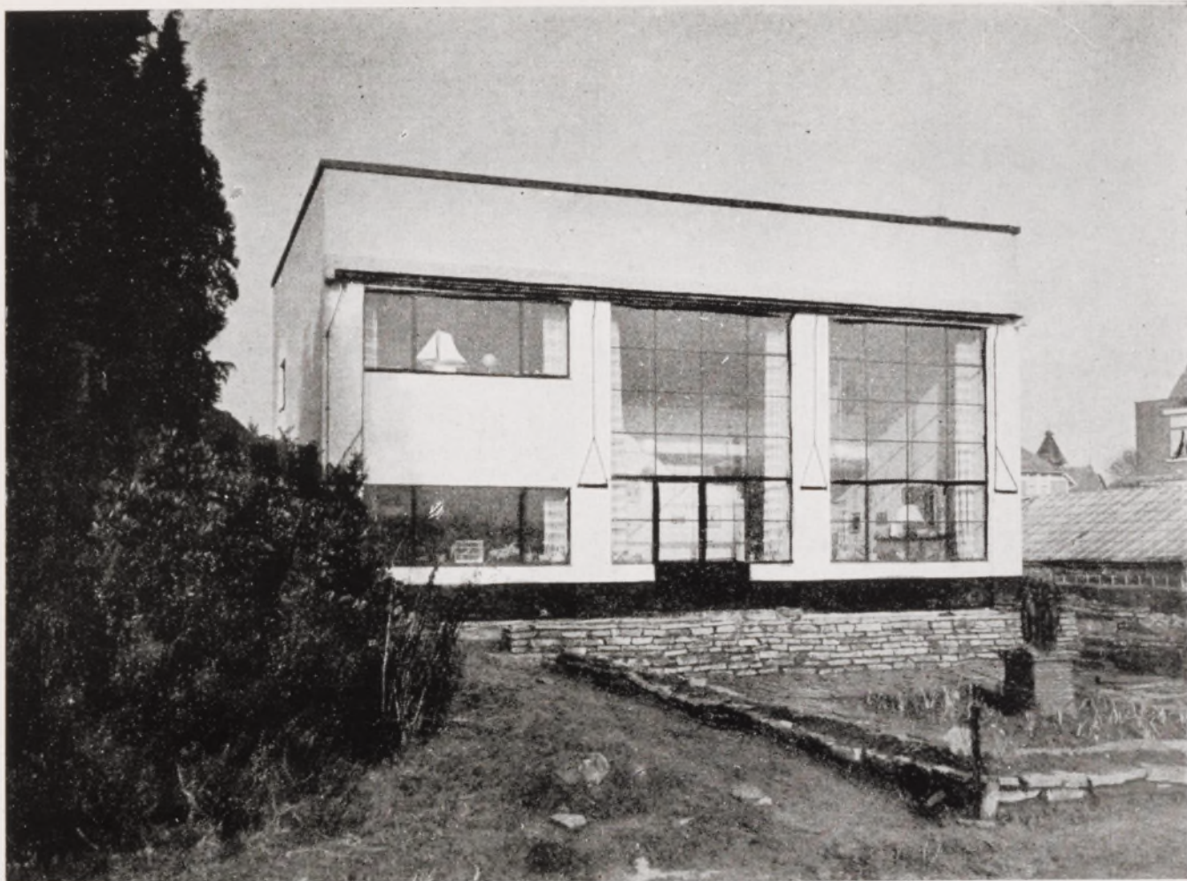
357. Villa à Boitsfort. Façade vers le Sud.
